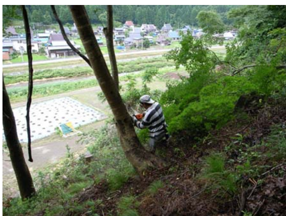
写真3 伐開作業。作業地の向こうには、菅並の集落が広がる(2009年7月)
