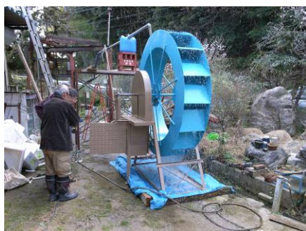
写真 13 出来上がった水車発電システム。まずは、ホースで水をかけて発電実験
