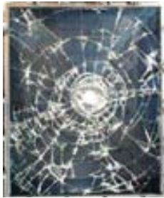
周辺部に亀裂あり フィルム厚 350 μ m
