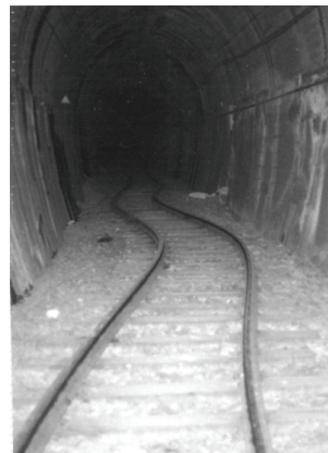
図1.1.8 伊豆急行線稲取トンネルの被害 3), 5) (左：覆工の破壊，右：レールの蛇行)
