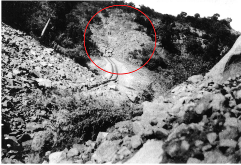
図1.1.4 熱海線寒ノ目トンネルの被害 6) (斜面崩壊によるトンネル崩落)
