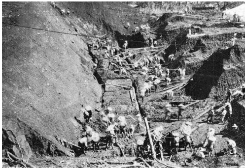
図1.1.6 中央本線與瀬トンネルの被害 6) (坑口部付近の小土被り区間の崩落)
