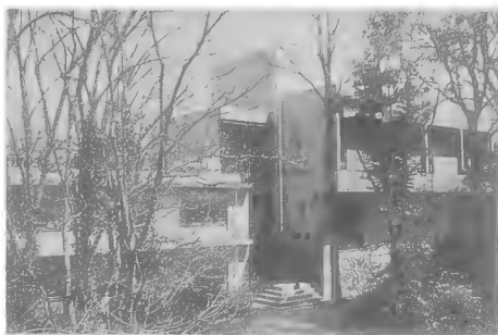
写真42-6 植物生態研究施設の建物。京都市左京区北白川西町所在。1981(昭和56)年撮影。生態学研究センターの所蔵による。
