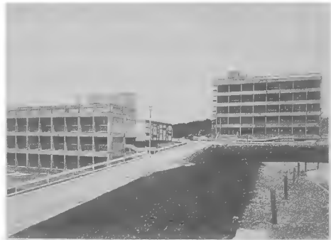
写真27-3 第2期工事終了(1969年5月)
