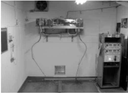
図1 (株)巴商會が納品した液体窒素供給システム。右隅が充填制御盤。
