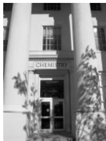
図3 玄関付近近影,2階右端 が筆者らの居室兼実験室
