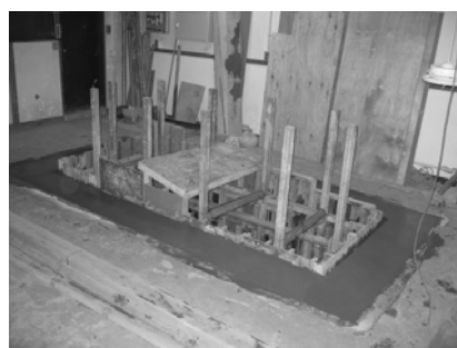
図3 ピット型枠にコンクリートが流し込まれたところ(2004年12月)
