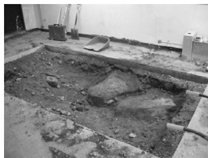
図2 ピット工事開始(2004年11月)
