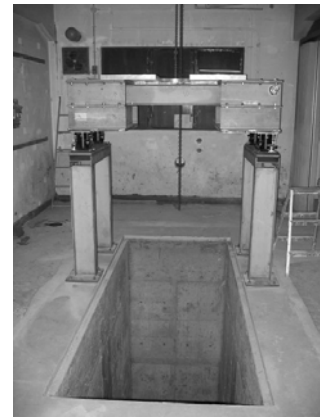
図4 ピット及び架台が完成したところ(2005年1月)
