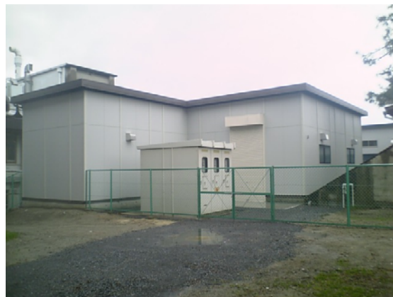
図1 ダークマター実験棟。物理棟側から撮影。正面に見えるのは、電源設備で、実験棟の裏はLTMセンターである。
