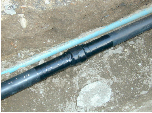
図2 熱収縮チューブを被せたSUS-50A管の差込溶接継手付近。漏れテスト終了後にテープ巻き処理したところ(吉田南構内, 2007年1月)。隣の細い水色管は, ポリエチレン外面被覆の既設25A鋼管(1996年頃施工分)で, 今回廃止。
