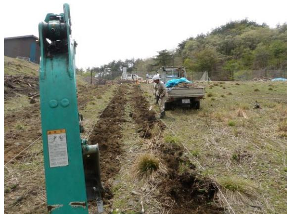
写真4 林道残土の斜面にカヤを移植
