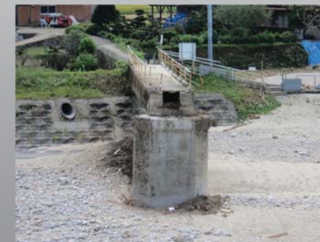
岩盤基礎まで洗掘された橋脚は流失
