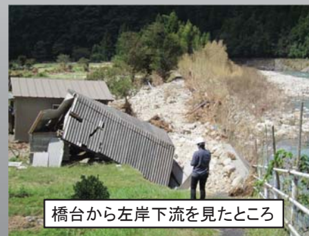
左岸が洪水で浸食 国道169号に架かる橋梁
