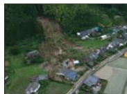
下手仲間地区の土石流 (鹿児島県姶刈町)
