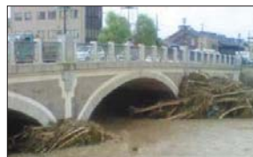
浅野川大橋の流木堆積状況(金沢市)
