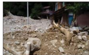
土砂災害により人家2戸半壊(南砺市)
