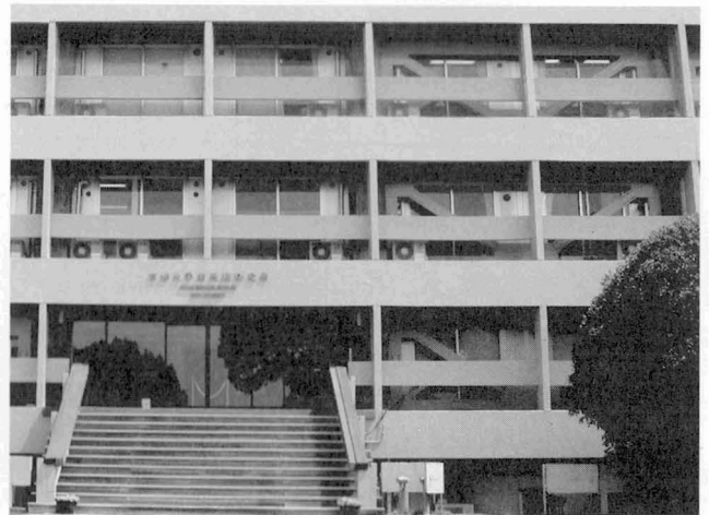
耐震補強のため付設された鉄骨
