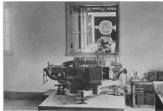
(右) 旧太陽館でのアスカニア製ヘリオグラフとグラブ製シーロスタット。
