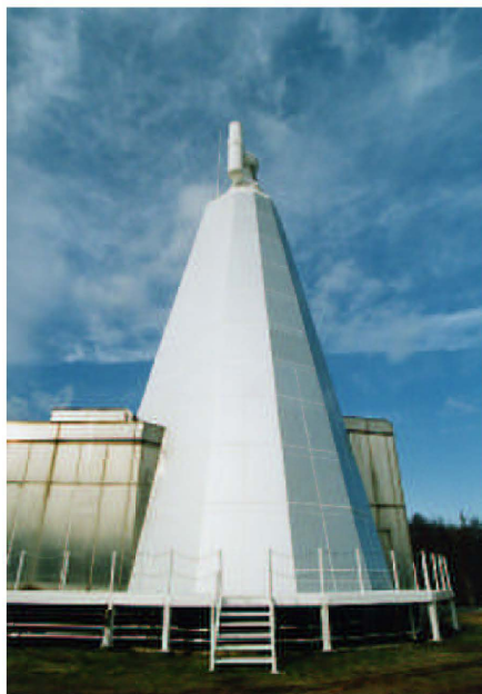
新装なった塔体冷却パネル
