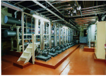
(左) 塔体冷却システムの機械室 (右) ブラインチラー (冷凍機)
