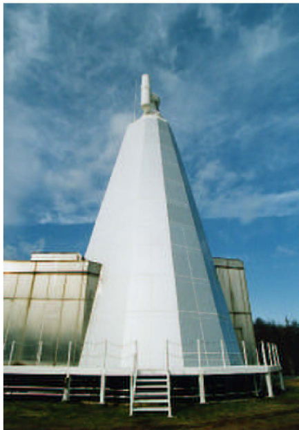
新装なった塔体冷却パネル
