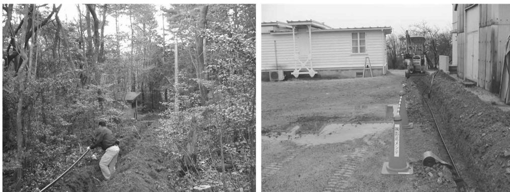
給水管改修工事: 管路掘削、配管状況
