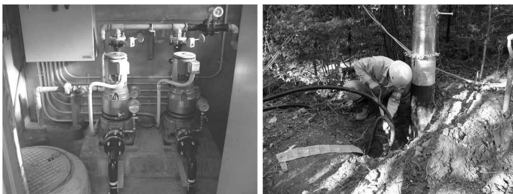
(左) 新設ポンプ取付 (右) 建柱、配線状況
