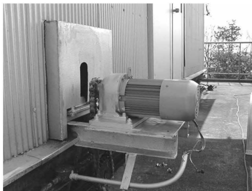
新設モーター取付
