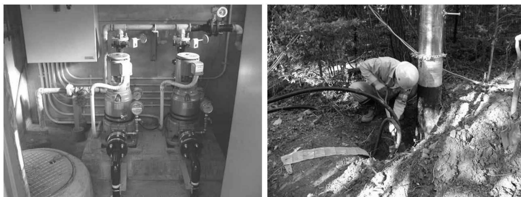
(左) 新設ポンプ取付 (右) 建柱、配線状況
