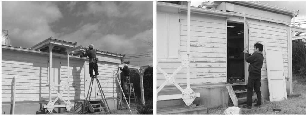
(左) 屋根樋の設置 (右) 入口扉の取替
