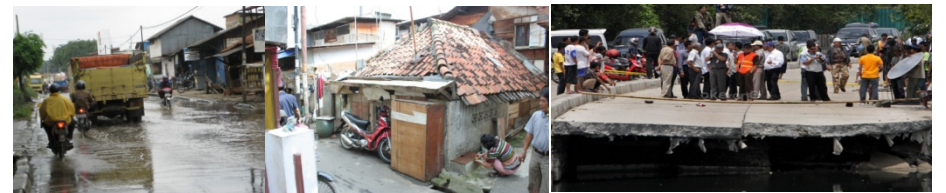
図 3. ジャカルタ市内における地盤沈下の被害状況:(左) Kapuk Dalam 通りの大洪水、(中) Mangga dua 地域に地盤沈下、(右) Ancol 市に崩落した高速道路
