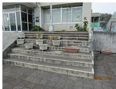
写真-2 玄関前の階段増設
