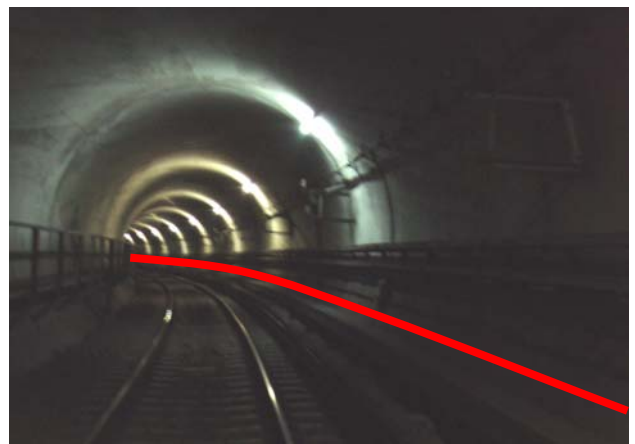
写真-2 連結2次元変位計の設置位置
