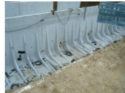
土圧計取付状況
