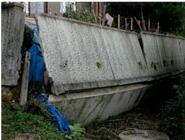
*擁壁の崩落
