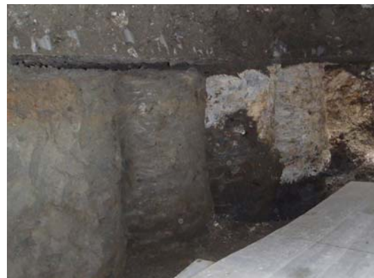
写真 1 柱状改良体と二水石膏 (奥)
