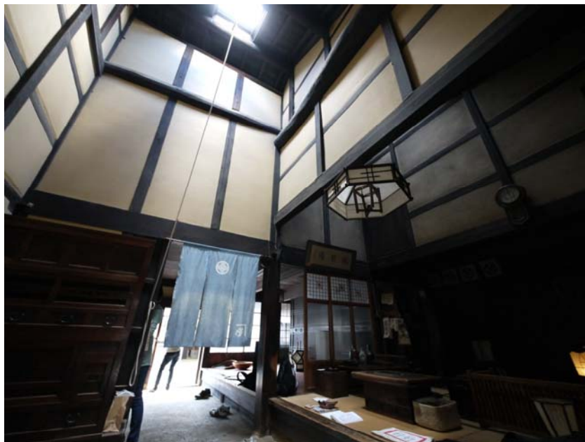
トオリニワ付近の開放的空間、大きな垂壁
