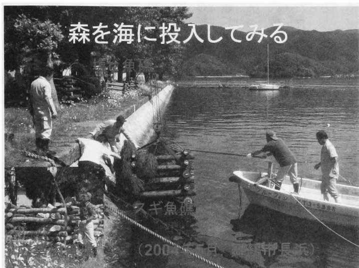
写真① 間伐材で作った魚礁を海へ投入
