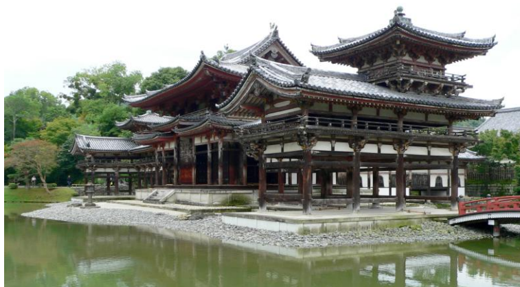
Figura 3 – El Templo Byodo-in (Uji – Japón) antes de la restauración (2012-2014)
