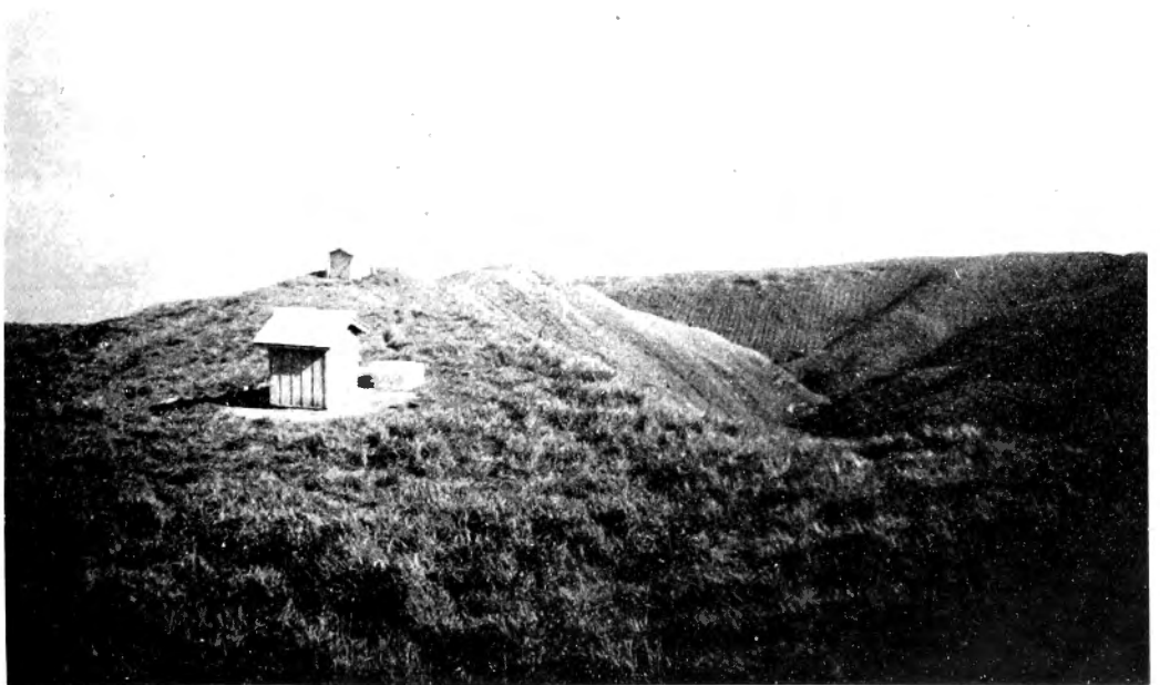
阿蘇山中腹千里ヶ濱に於ける地磁氣觀測施設 (變化計室は地下16米に在る)
