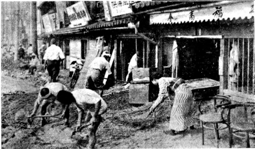
同布引瀧道の土石流堆積
