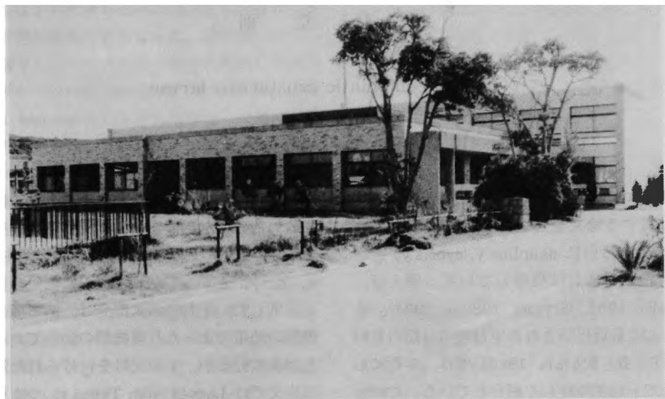
本館北側（実習室・講義室）
