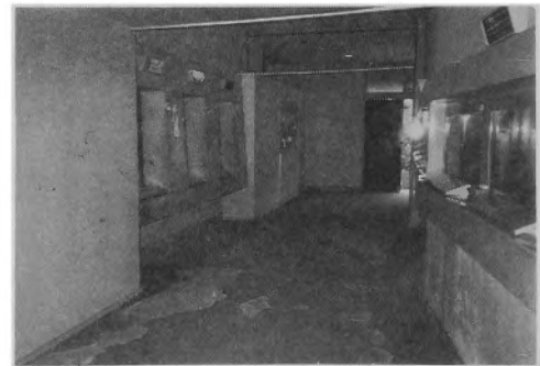
一部を閉鎖した第4水槽室
