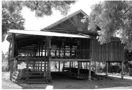
写真2 サラー・チョーティアンと呼ばれる施設の建物
