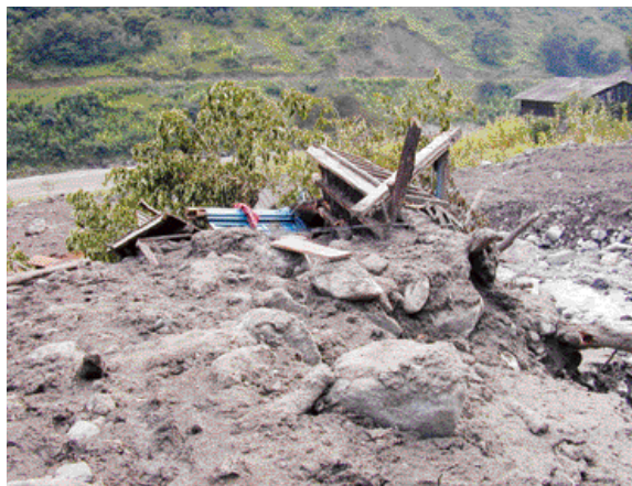
土砂崩れによって倒壊したサルウィン川上流域のリスの人びとの家屋。サルウィン川流域では、山腹から河畔への移住が進んでおり、地形的に不安定な崩壊地に家を建設する場合も多い
