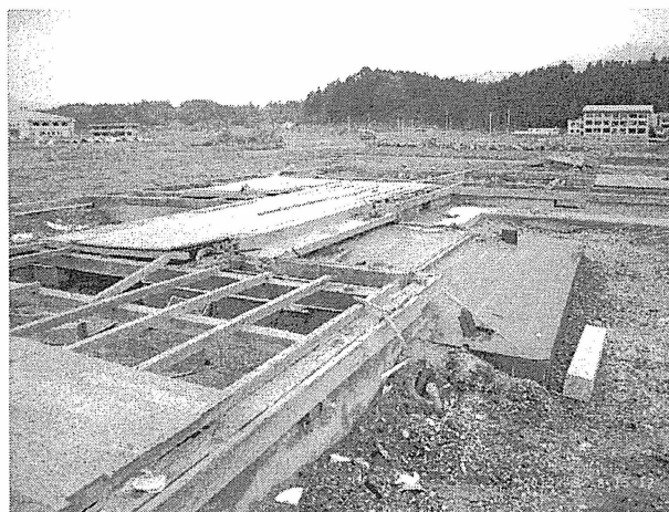
写真 3.3.3 高田高校（背後の建物）の南方、国道45号線近くの木造建物の床
