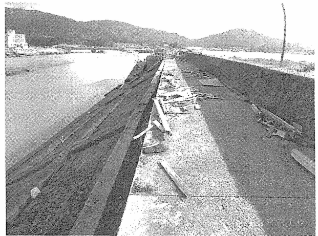
写真 3.3.13 高田松原の僅かに損傷した防潮堤
