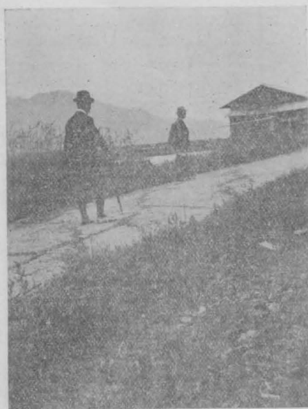
桃島道路及水田龜裂
