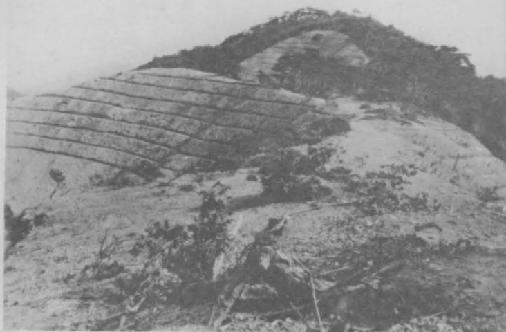
宇治郡黄檗山裏の古生代砂岩の上にて砂防工事
