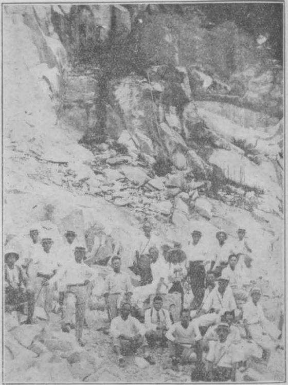
岡山縣久米郡佐良山村 石英粗面岩の石切場
