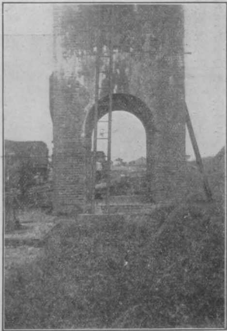
第五圖 新營驛構內給水タンク脚部の被害
