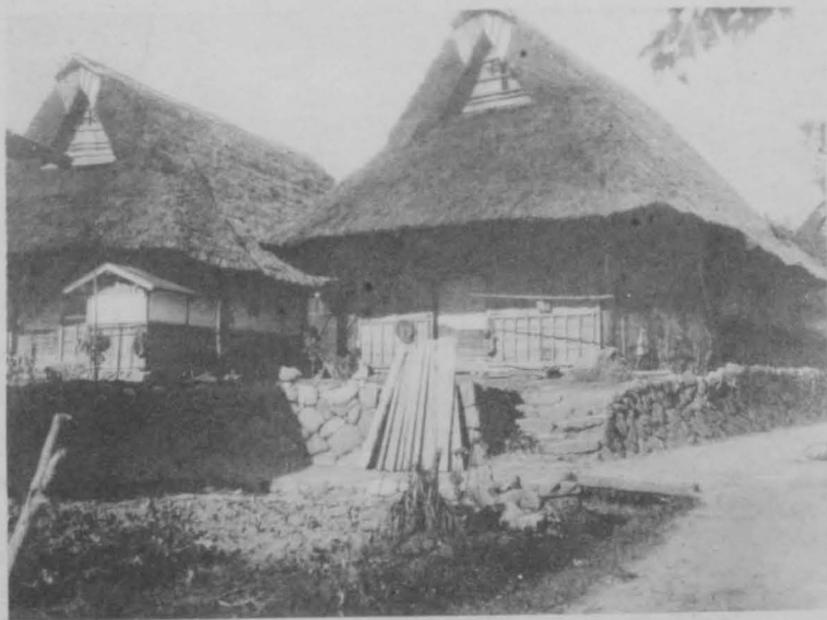
第二圖 甲津原の民家
