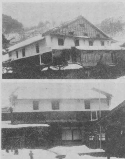
但馬に於ける屋切り造の家屋 上圖は側面、下圖は正面、悠汀撮影
