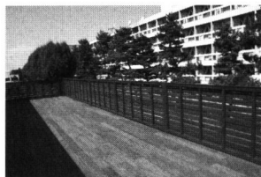
二階ウッドデッキ
