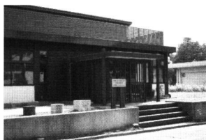
材鑑調査室工事後の外観
