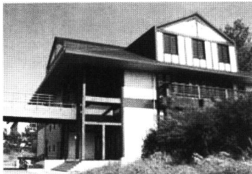
写真1 木質材料実験棟全景
