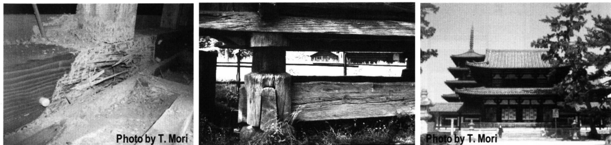
図1：木材の生物劣化、風化、老化（左：シロアリおよび腐朽菌による劣化、中央：風化、右：法隆寺部材の老化）
