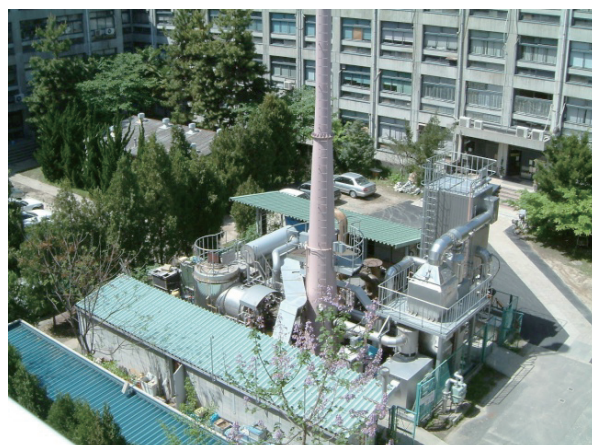
2001年3月 ダイオキシン対策用にバグフィルター、触媒塔の設置
