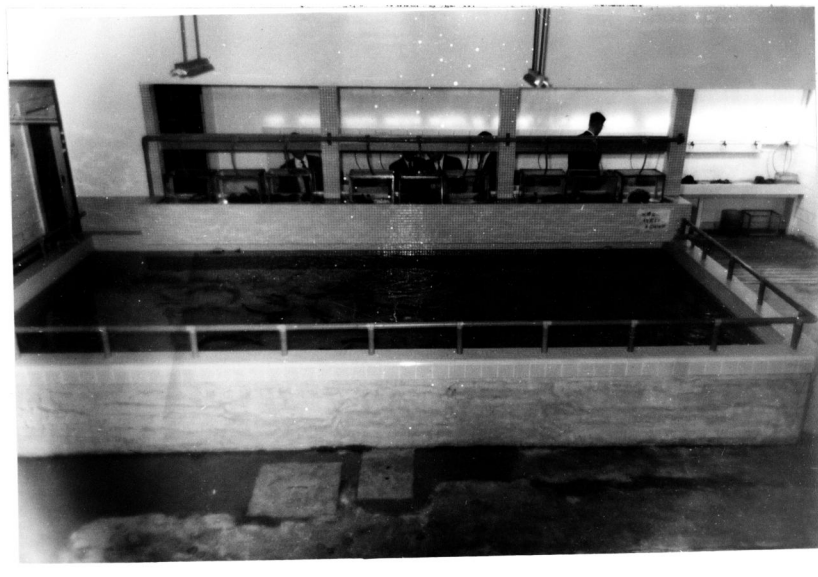
大水槽と卓上水槽 大水槽はうす青色のタイル張り，縦2.80 m，横6.0 m，深さ0.9 m，容量約150 屯，水かわりもよく，魚疾の治も良好。
