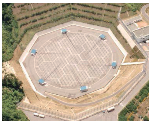
信楽 MU 観測所の MU レーダー（アンテナ直径 103m, 送信出力 1MW）
