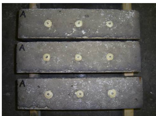
(b) 暴露開始から 28 週経過時のひび割れ状況 (S-I-20w (非反応性骨材種：S 種, 配合：No.I, 暴露環境：20℃-水中))
