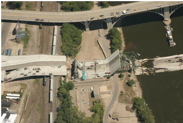
(a) I-35w 橋の落橋状況
